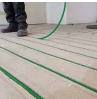
Montage der Flächenheizung (z.B. CUT-THERM®)
