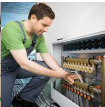
Inbetriebnahme des EMPUR® GeniAx Wärmeverteilsystems
