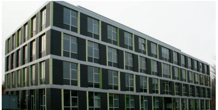
Das Zentrum für Biomedizintechnik (ZBMT) auf dem Campus der RWTH Aachen setzt auf Wilo-Geniux, den intelligenten Komfort-Manager für das Heizen und Kühlen.
